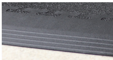
縁駒の取り付けにより、段差が無くなります。
