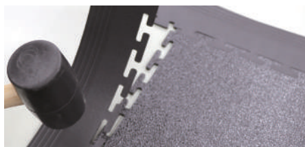
施行はハンマーで打ち込むだけ。
